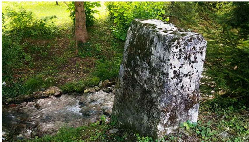
Betonski temelji potpornih stupova još i danas nijemi svjedoci minulog vremena (Foto: Boris Jagetić Daraboš, 2016. godine)
